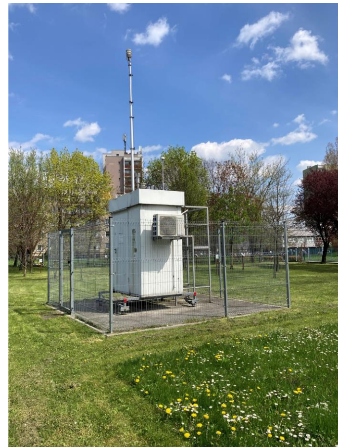
Stacja pomiarowa w Opolu, ul. Koszyka
